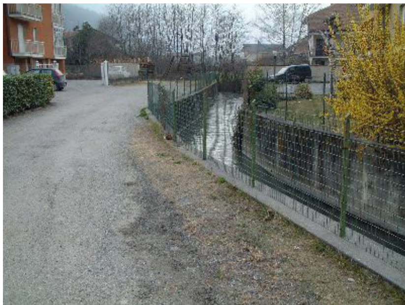
Canale Cantarana sez. 45 a monte
