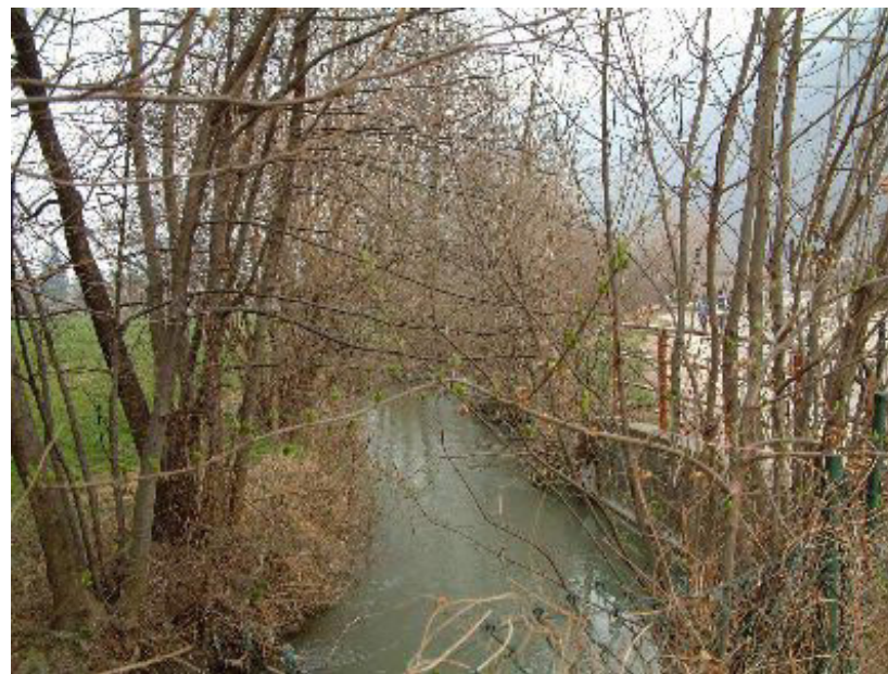
Canale Cantarana sez. 40 a valle
