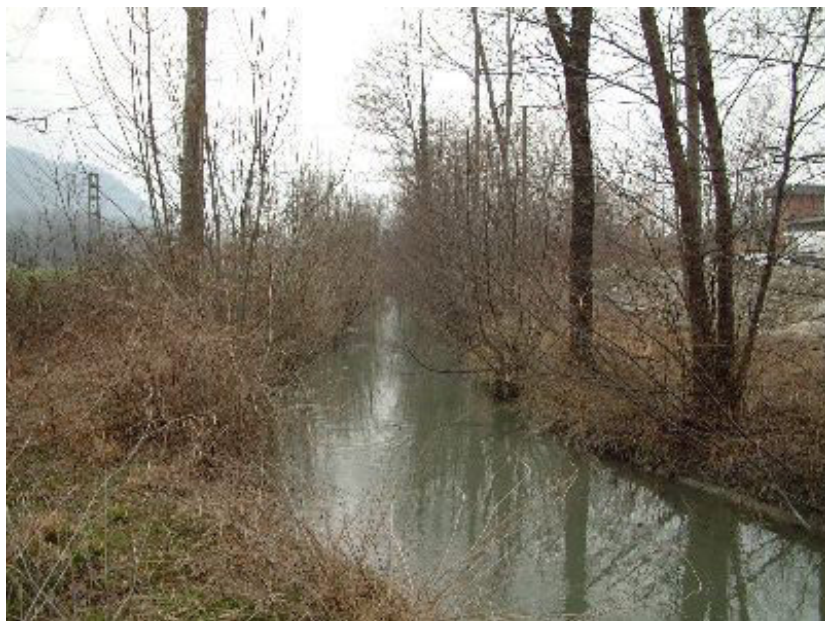
Canale Cantarana sez. 21 a monte
