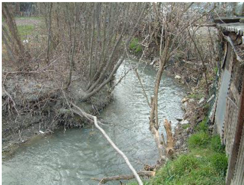
Canale Cantarana sez. 25 a valle
