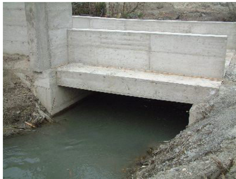
Canale Cantarana sez. 24 a monte
