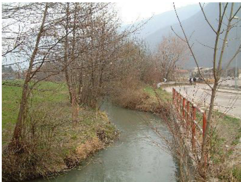
Canale Cantarana sez. 39 a valle
