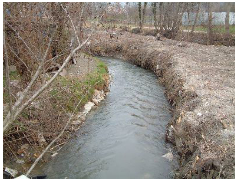
Canale Cantarana sez. 24 a monte
