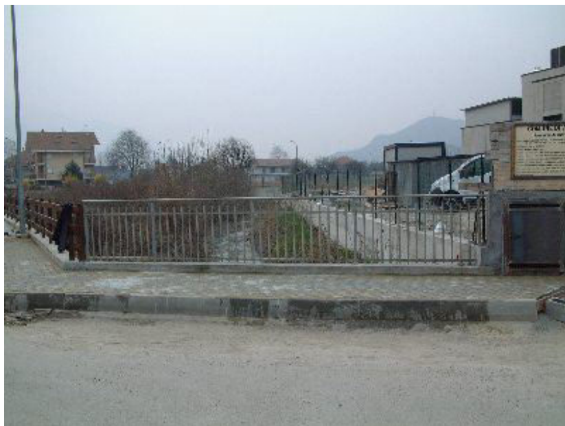
Canale Cantarana sez. 41 a monte
