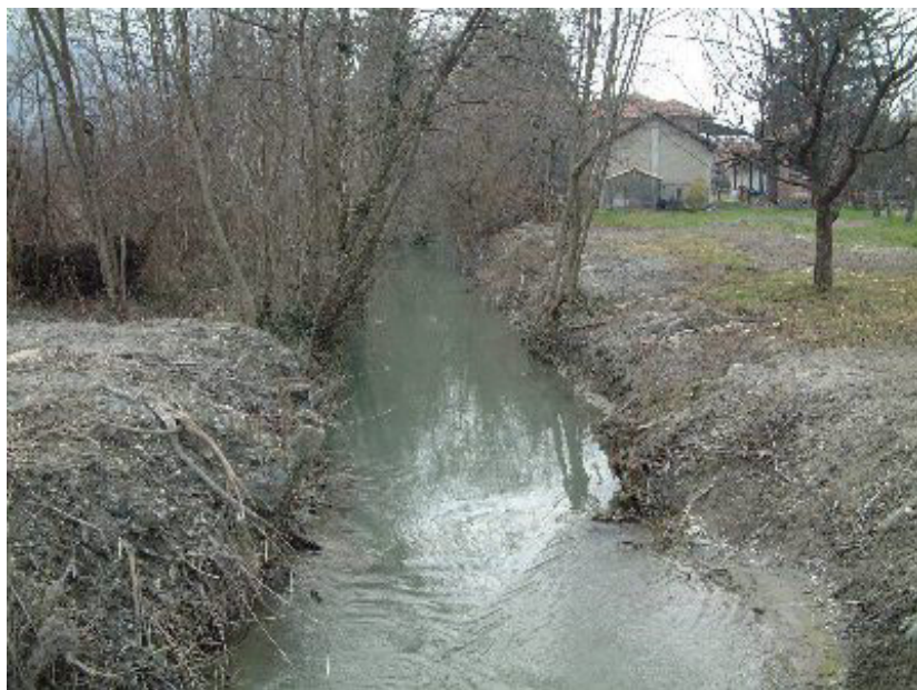
Canale Cantarana sez. 24 a monte
