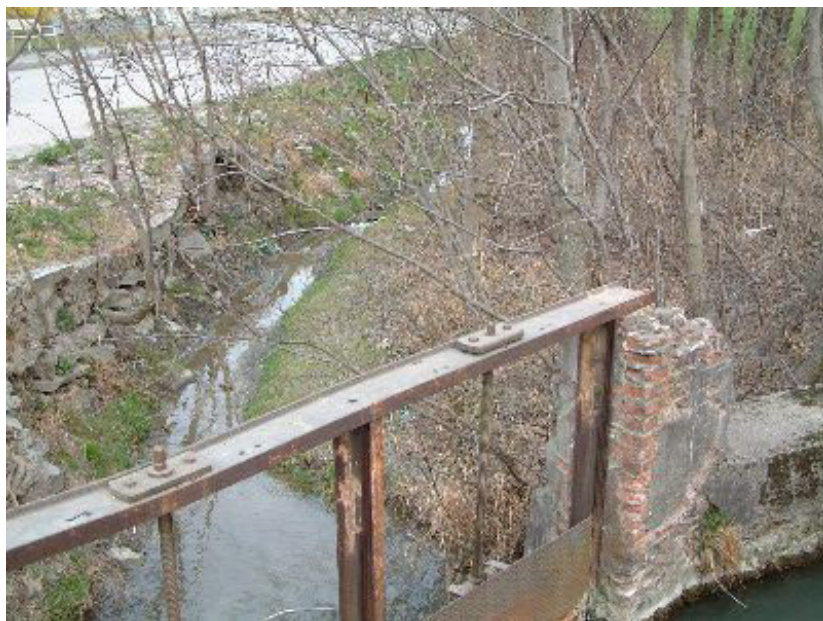
Canale Cantarana sez. 41 a valle
