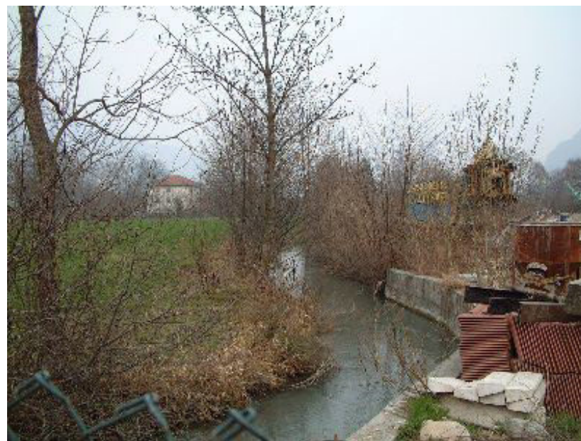
Canale Cantarana sez. 37 a valle
