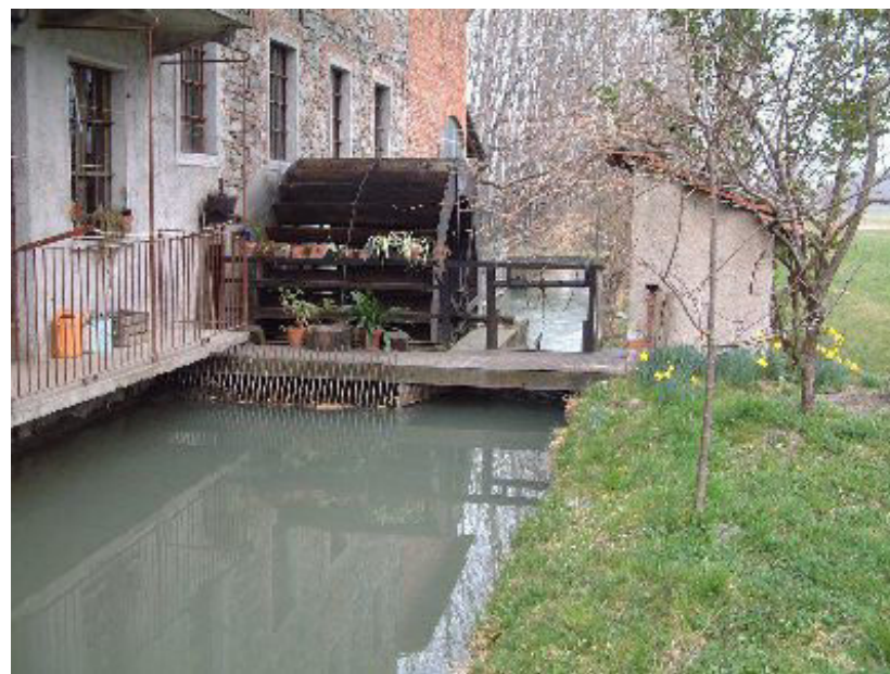
Canale Cantarana sez. 13 a valle
