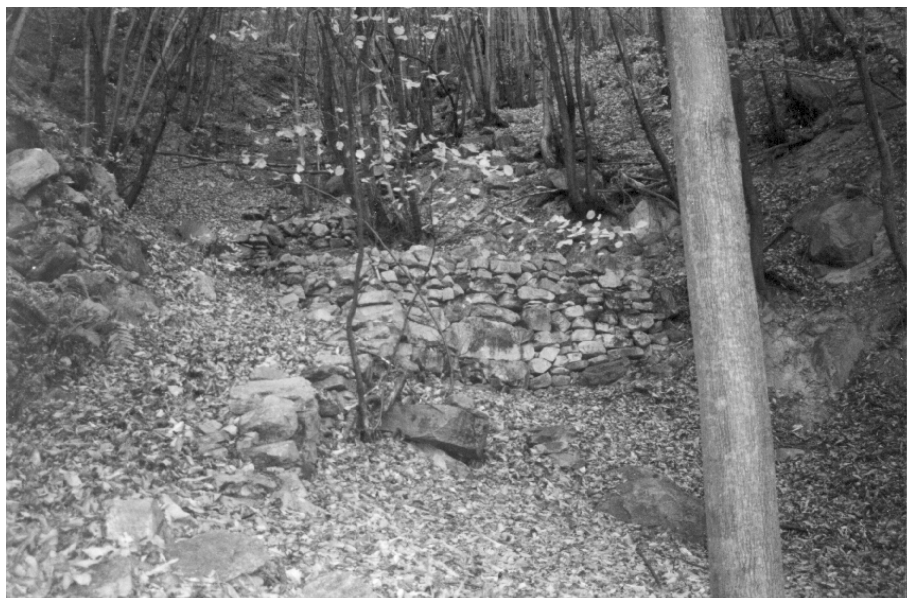
Figura 5: Briglie in pietra a secco. La briglia in primo piano risulta ancora ben conservata mentre quella in secondo piano, posta più a monte, appare parzialmente smantellata. Versante, a sud di Vaie, quota 660 m circa (scheda censimento n. 10, allegato n. II).
