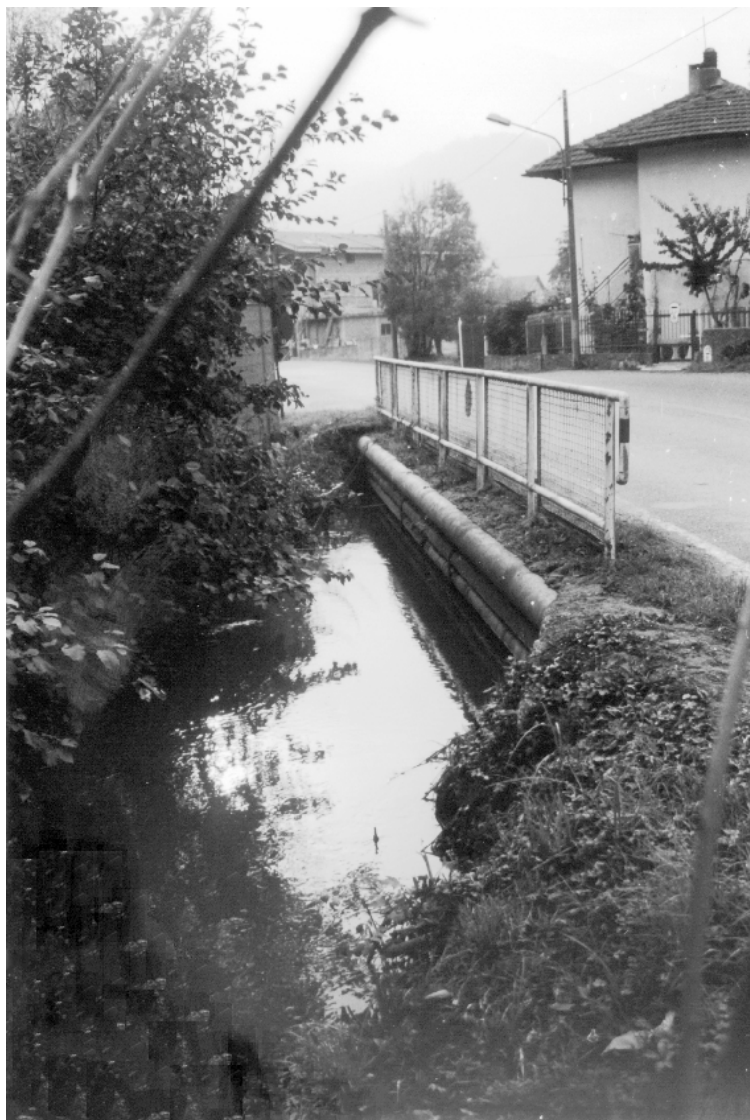
Figura 8: Attraversamento del canale del Molino o Cantarana, Via Torino. Nei pressi del Molino la sezione di deflusso, in condizioni di portate normali, è quasi interamente occupata (scheda censimento n. 7, allegato n. II).
